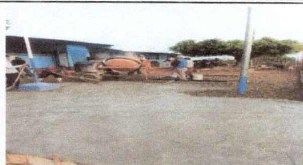
Foto 2: Colocación del piso en el corredor de las aulas.
