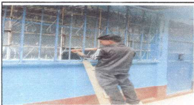
Foto 3: Colocación de los vidrios de las ventanas.
