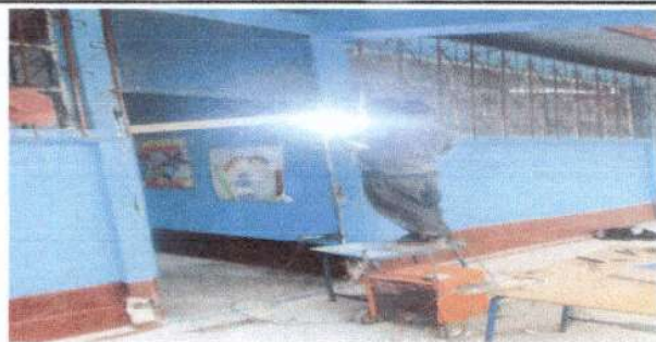
Foto1: Instalación de chapas de la dirección y las aulas
