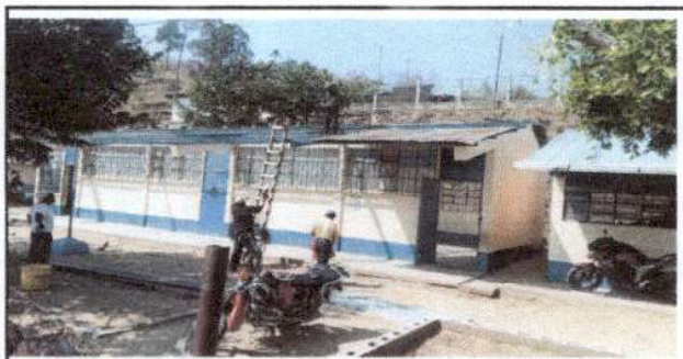
Foto 5: Desinstalación de las láminas antiguas del techo de las aulas.
