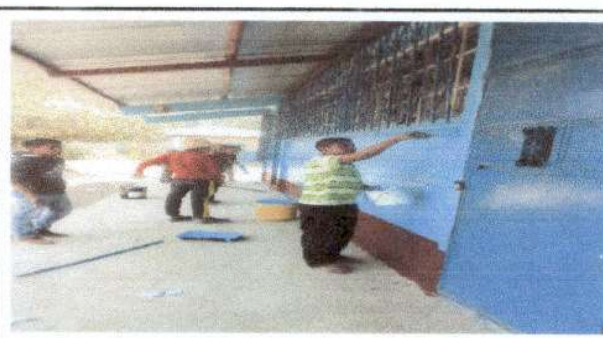
Foto 4: Pintada de paredes interior y exterior de las aulas de los dos módulos.
